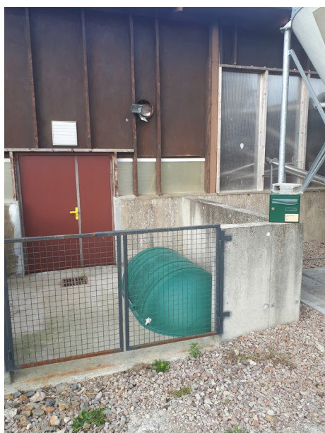
Exemple d'aire d'équarrissage sur une zone bétonnée, clôturée et équipée d'une cloche à cadavre
