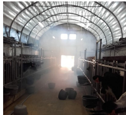
Détection des courants d'air indésirables et vérification de la bonne mise en mélange de l'air entrant avec l'air ambiant à l'aide de fumigènes
